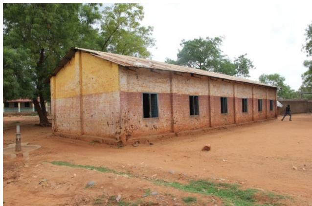
Verputz fehlt. Das Blechdach ist komplett verrostet. In der Klasse stehen die Bänke auf staubigem Erdboden. Der Wandverputz im Inneren des Raumes weist viele Löcher auf. Die Decke fehlt, so dass die gesamte Dachstuhlkonstruktion sichtbar wird. Wenn die Sonne auf das Dach scheint, entwickelt sich
