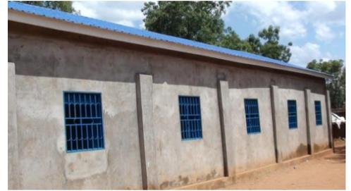
Doppelgebäudes. Bis Ende September 2016 wurde eine neue Decke eingezogen, ein Estrich gelegt, Fenster und Türen eingesetzt und Elektroinstallationen vorgenommen.
