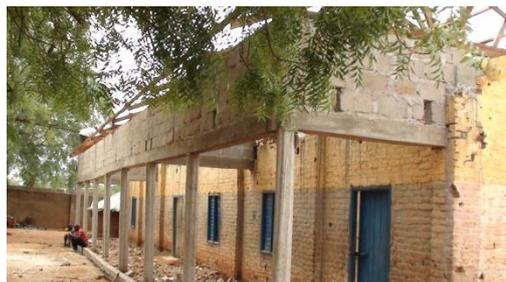
Dem folgten der Anbau der Veranda (Regenschutz) und die Anfertigung eines neuen Dachstuhls mit einer neuen Dachabdeckung
